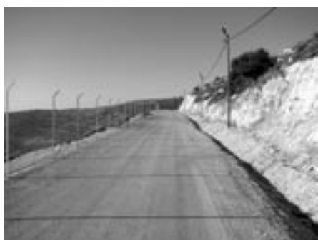
מערך מכשולים בהקמה סביב ההתנחלות מעלה לבונה, הרחק מבתיה, ינואר 2008. המערך כולל, עם סיום העבודות, גדר תיל עם מרכיבי התרעה אלקטרוניים, דרך סיור ותאורה היקפית.
